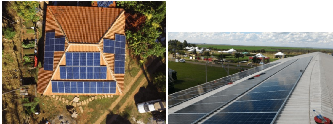
Figuras 8 e 9. Aquisição e instalação de sistema de energia fotovoltaica financiada pelo FDR
