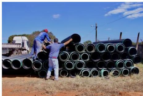
Figura 3. Tubos de PEAD utilizados para tubulação de canais de irrigação
