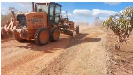
Figura 1. Atuação da Seagri-DF na infraestrutura das áreas rurais - manutenção de estradas rurais não pavimentadas
